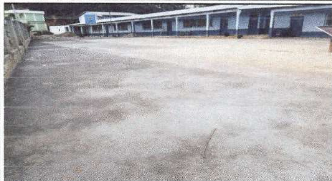
Foto1: Sustitución de torta de concreto, patio de la escuela.
